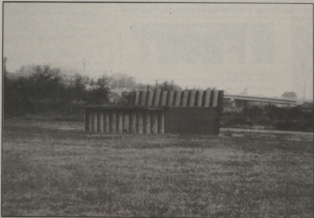
Vallé dans quel état se trouvait l'un des abris du terrain de soccer après le passage de l'ouragan "BOB". Relevé en fin de semaine dernière, l'abri aurait cependant encore d'un bon coup de pouce. Les premières parties régulières sont prévues pour le fin de semaine prochaine. Avis aux personnes concernées!
